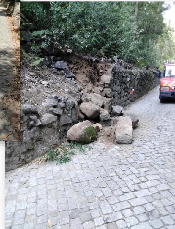
Durante o mês de agosto foram realizadas duas intervenções no âmbito da proteção civil que envolveram a demolição parcial de muros em risco de queda para a via pública e a remoção de inertes para vazadouro.
