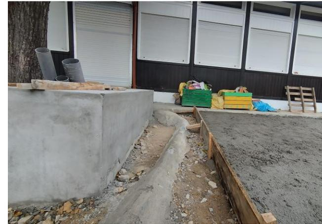
Nesta zona, está a ser melhorada a drenagem de águas pluviais, eliminado o desnível verificado entre o passeio junto ao edifício e a área envolvente e construída uma caldeira/banco para preservar a árvore existente.
