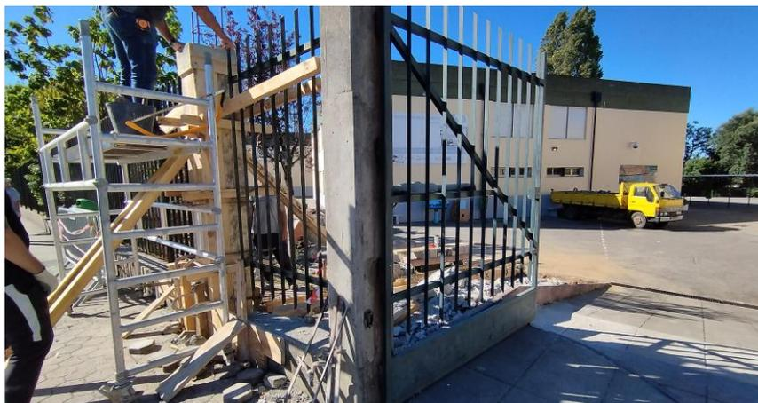
Foi concluído o melhoramento do acesso à Escola D. Pedro I, pela Rua Nova do Fojo, mediante o alargamento do acesso viário, que implicou a deslocação dos mastros, o alargamento da rampa, a construção e aplicação de guarda, o prolongamento da drenagem de águas pluviais e a substituição do portão de duas folhas por um portão de correr.
