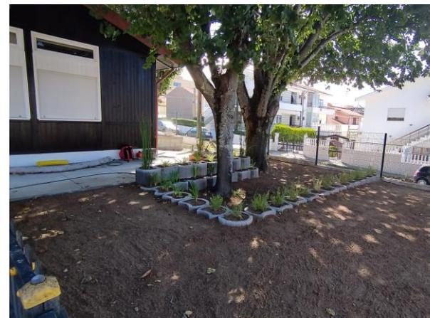
Na área envolvente a duas árvores, foram montadas caldeiras prefabricadas de betão, de forma a garantir uma solução orgânica e adaptada à topografia existente, permitindo diminuir os desníveis verificados sem enterrar os seus troncos.
