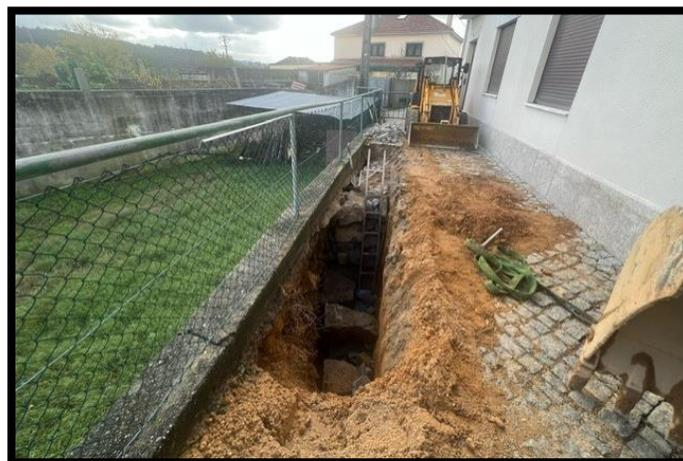
Na Rua da Fábrica, em Lever, procedemos à reparação de um muro de suporte da via, que se encontrava em risco de queda.
