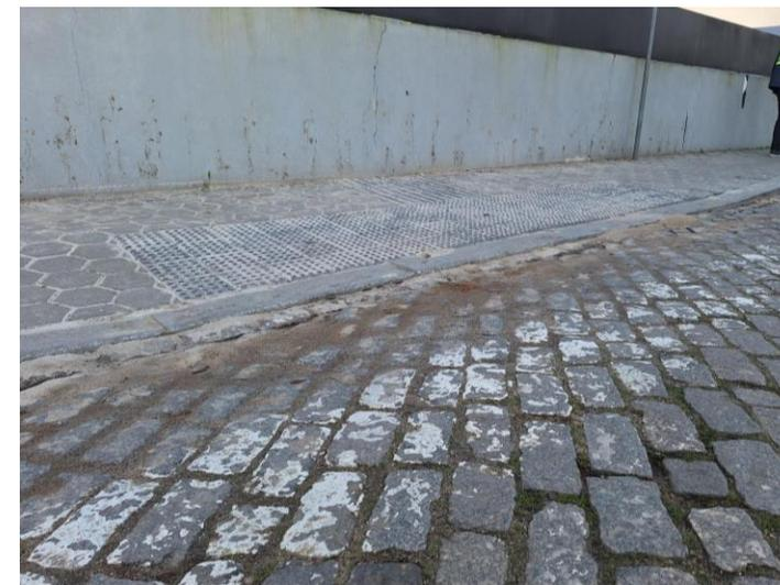
Na Rua da Estrada de Cima, em Arcozelo, estamos a realizar a eliminação de parte da área destinada a baía de estacionamento, prolongando a zona de passeio e permitindo melhorar as condições de segurança e acessibilidade na aproximação ao atravessamento pedonal existente. Aproveitamos , ainda, para realizar o rebaixamento dos passeios e aplicar o pavimento tátil.
