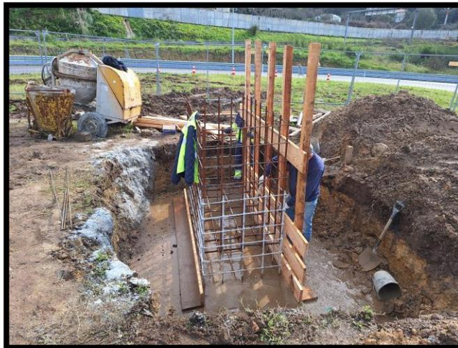
Foi efetuada a limpeza e o nivelamento do terreno para a construção de fundação em betão armado para montagem de escultura e foi instalada drenagem de águas pluviais e os negativos para as infraestruturas de iluminação a instalar.
