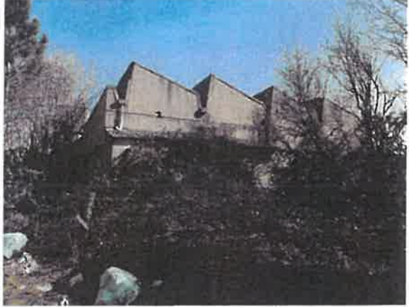
Foto n.º 04 – Fachada lateral direita da edificação
