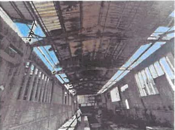
Foto n.º 05 – Vista da cobertura pelo interior
