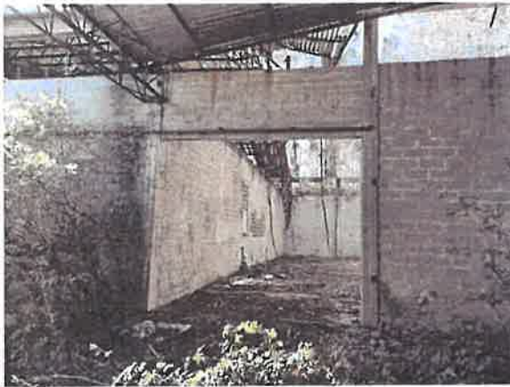
Foto n.º 07 – Vista da cobertura pelo interior
