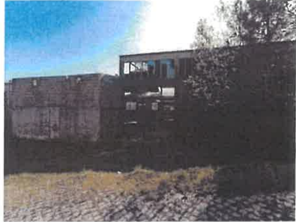
Foto n.º 02 – Vista da zona de entrada da edificação
