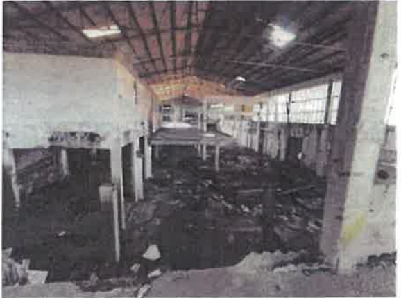
Foto n.º 06 – Vista da cobertura pelo interior
